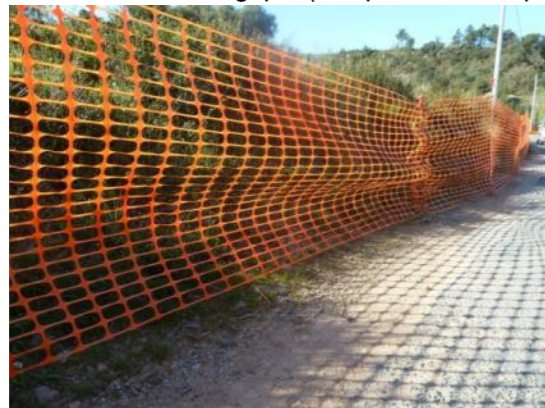
Exemple de dispositif de mise en défens temporaire des emprises chantier
