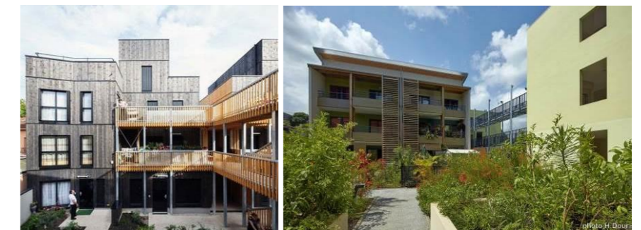
Exemples de bâtiments avec coursive extérieure
