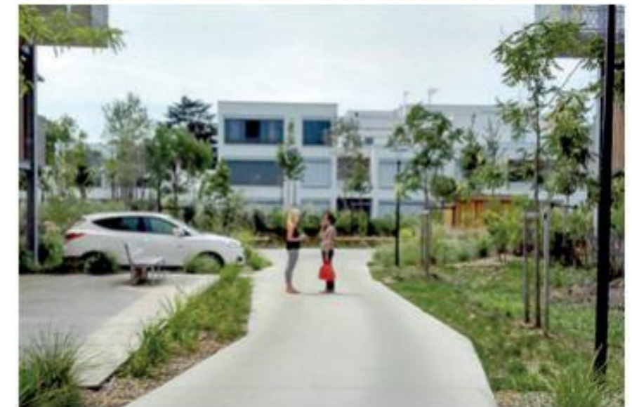
Quartier en zone de rencontre. La chaussée est dimensionnée à 3,5 m, entourée de verdure et de plantations. La rue est à double sens cyclable, elle accueille le cheminement de tous. Avec cette chaussée unique, l'automobiliste sait qu'il peut rencontrer des piétons et des cyclistes.
