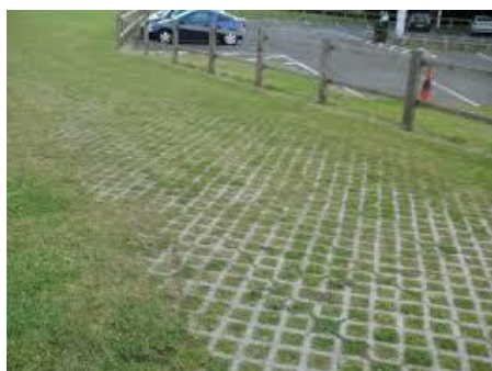
Exemple de sol drainant stabilisé >
