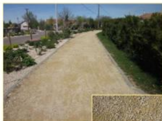
Stabilisé mécaniquement « STABILISÉ CALCAIRE »
