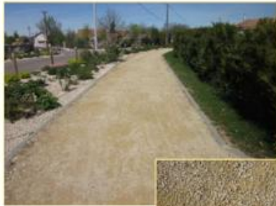
Stabilisé mécaniquement « STABILISÉ CALCAIRE »
