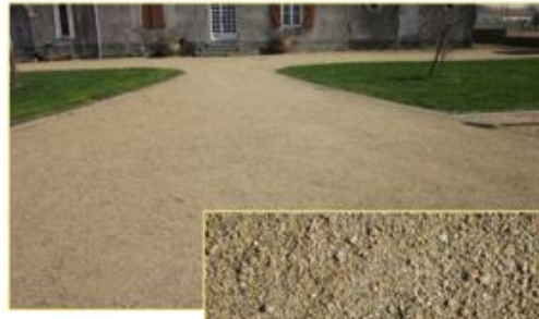
Stabilisé mécaniquement « CHAPE »
