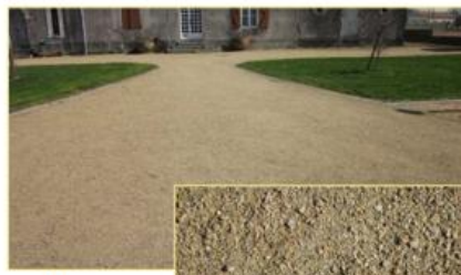
Stabilisé mécaniquement « CHAPE »
