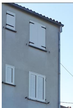
Contre-exemple : Styles hétérogènes sur une même construction.
