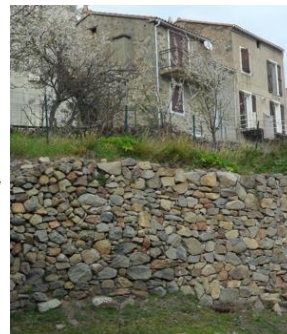
Exemple de murs de soutènement
